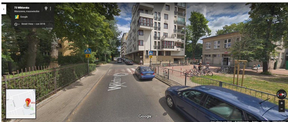
Rysunek 2 Dojazd do przejścia dla pieszych przed Szkołą Podstawową 69. Brak progu spowalniającego. Samochody parkujące przed samym przejściem. Zwracam uwagę na wąski chodnik po lewej stronie zdjęcia po którym często dzieci jadące np. na hulajnodze nie mają jak minąć się z innymi osobami idącymi z na przeciwka. Chodnik często zastawiony samochodami.
